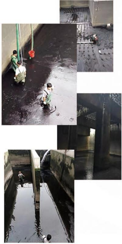
5月18日，迎来了我公司一年一度的生物池大修工作，之前各种准备工作，包括向雄县自来水打报告申请，向雄县环保局打报告，向雄县县城管局，向市局都一一打报告备案，与此同时，我们又做了安全准备工作，因为生物池毕竟有8米深，一定要做好安全准备。一切准备妥当，我们开始放水，冲泥，接电接管，沉淀池放水完毕后露出了斜板且垃圾很多，只能人工捡拾，我厂区员工不畏惧炎炎烈日，不畏惧臭气冲天，不畏惧危险，下沉淀池捡拾垃圾，为我厂生物池大修得以按质按量完成做了一项保障。接下来就是最严峻最危险的好氧池检修，好氧池深度达8米，且污泥很多，为了检修曝气头及各个设备，男同志们下到8米深的好氧池，用手伸在污泥里摸索曝气头并更换，粘接，虽然天气炎热，但是8米以下确是冰冷刺骨，为期半月的生物池检修，修完一区修二区，下面的人冰冷刺骨，上面的人汗如雨注，在这样的情况下，我分公司按时按质按量的完成了生物池的检修工作，每一位同事的积极态度，责任心，不怕脏，不怕危险的态度值得我们学习。公司是我家，发展靠大家，虽然挥洒汗水，但笑意盈盈，只要我们每一个人都齐心协力，定能与公司共创辉煌！（雄县分公司供稿）
